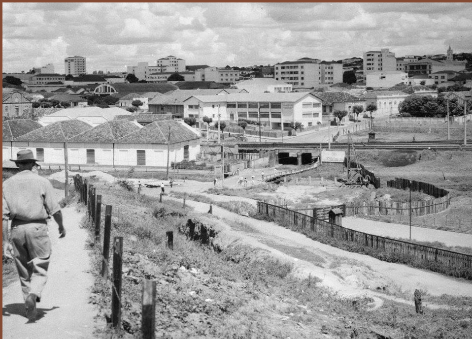
Figura 8: A passagem sob trilhos - Década de 1950
