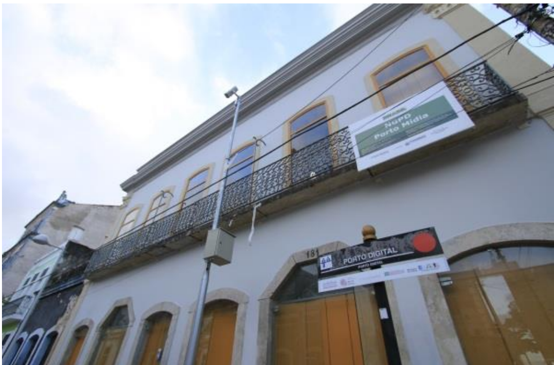
Figura 34 - Instalações Edif. Histórico no Recife antigo do PORTO DIGITAL - PORTO MÍDIA / PE
