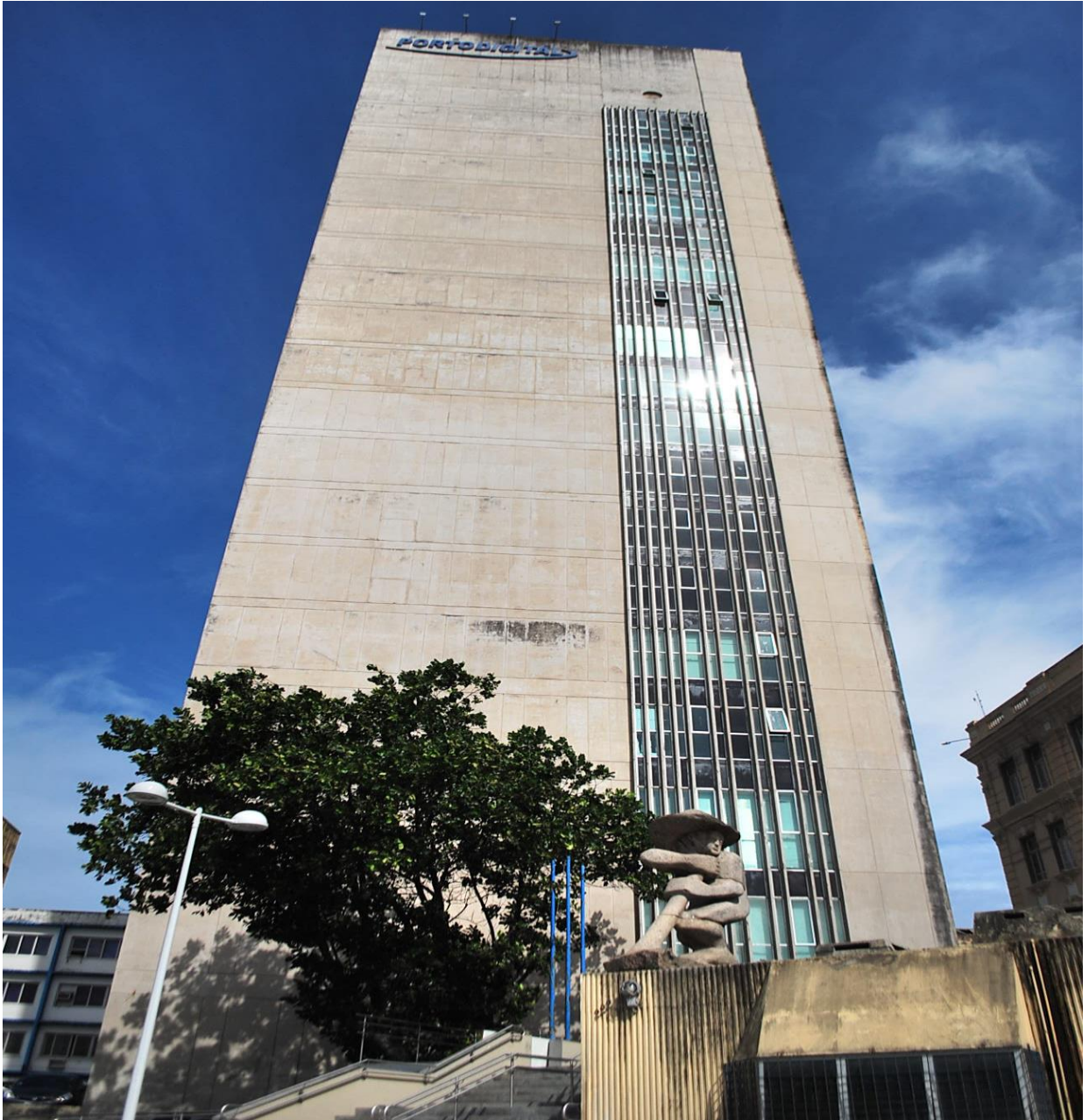
Figura 35 - Instalações Fachada antigo Edif. BANDEPE – Banco de Desenvolvimento de Pernambuco no Bairro Recife antigo - núcleo central do PORTO DIGITAL / PE
