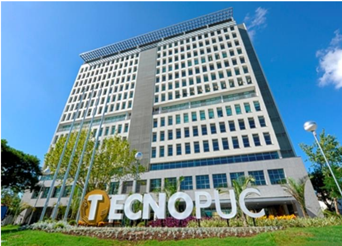
Figura 26 - Instalações Edif. principal Parque TECNOPUC / RS
