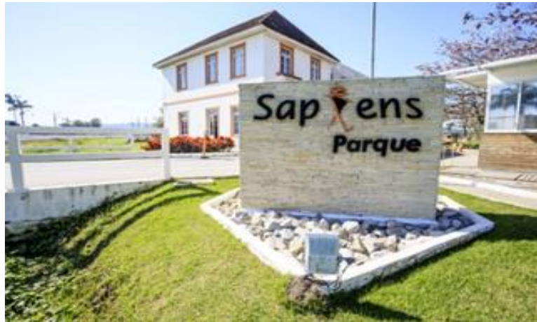
Figura 40 - Instalações – edif. histórico SAPIENS PARQUE / SC
