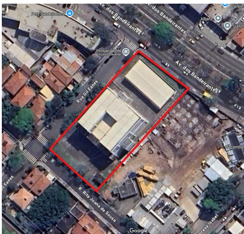
Figura 12. Imagem Aérea da Subestação Bandeirantes
