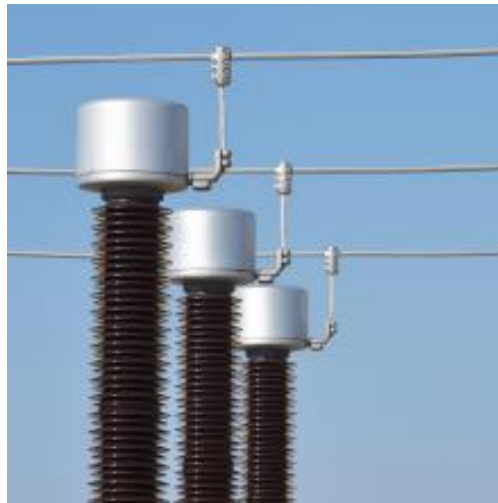
Figura 8. Transformador de Potencial
