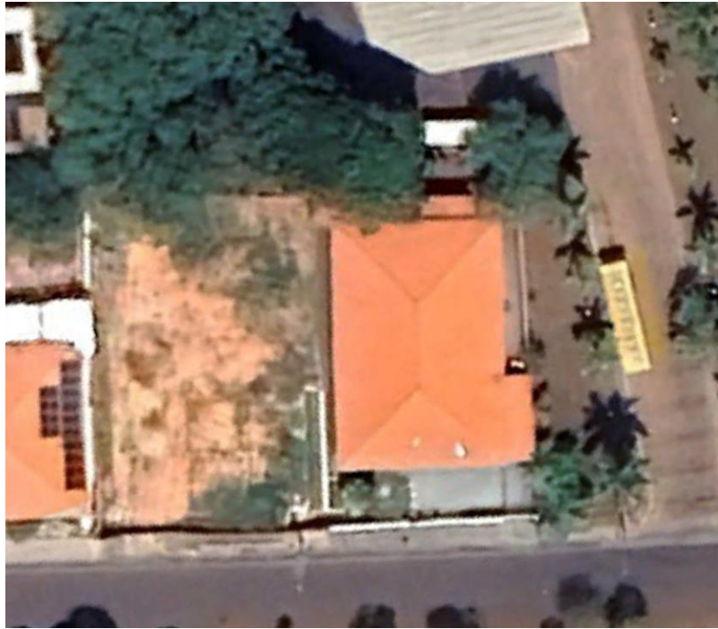
Figura 4 - Cobertura da APAE unidade Ribeirão Bonito.
