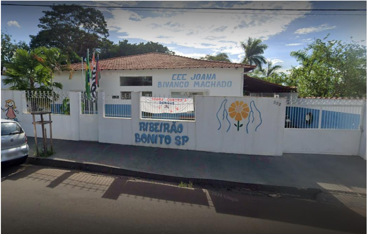
Figura 3 - Fachada da APAE unidade Ribeirão Bonito.
