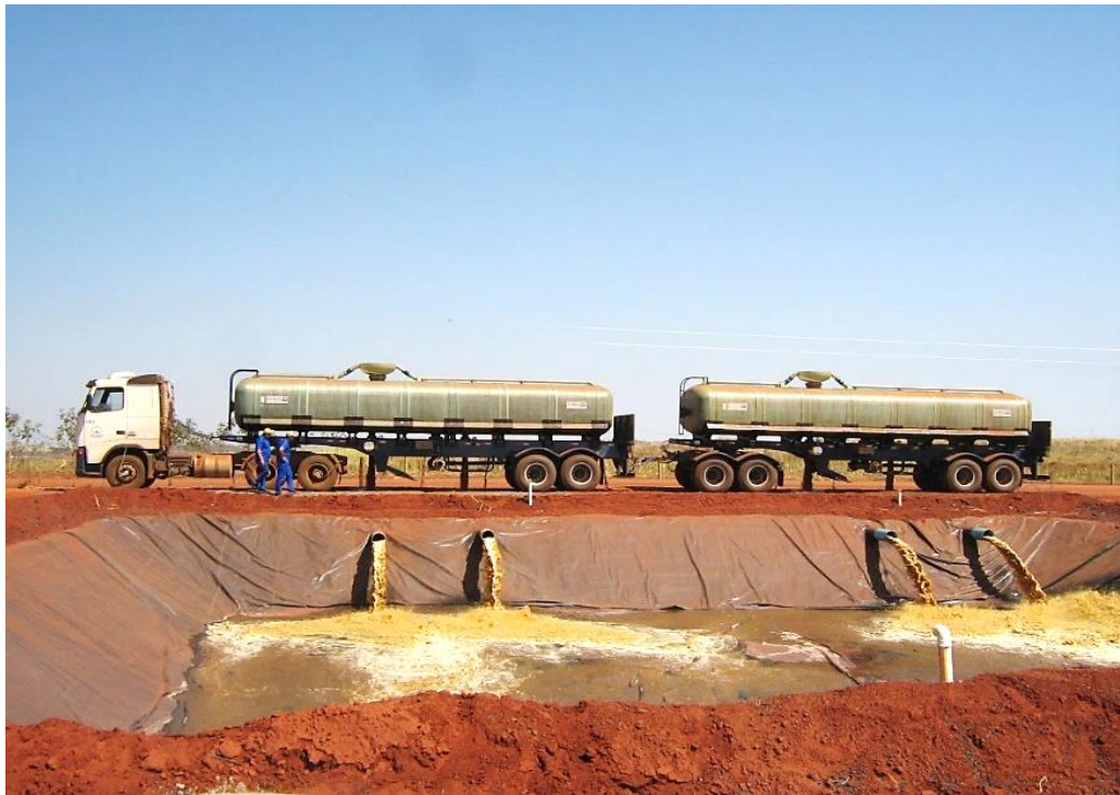
Figura 34 - Reservatório impermeabilizado na área agrícola com descarregamento de vinhaça transportada por caminhão
