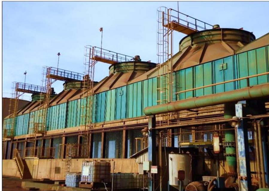
Figura 25– Torres de resfriamento de água para destilaria da Vale do Paraná S/A Álcool e Açúcar.
