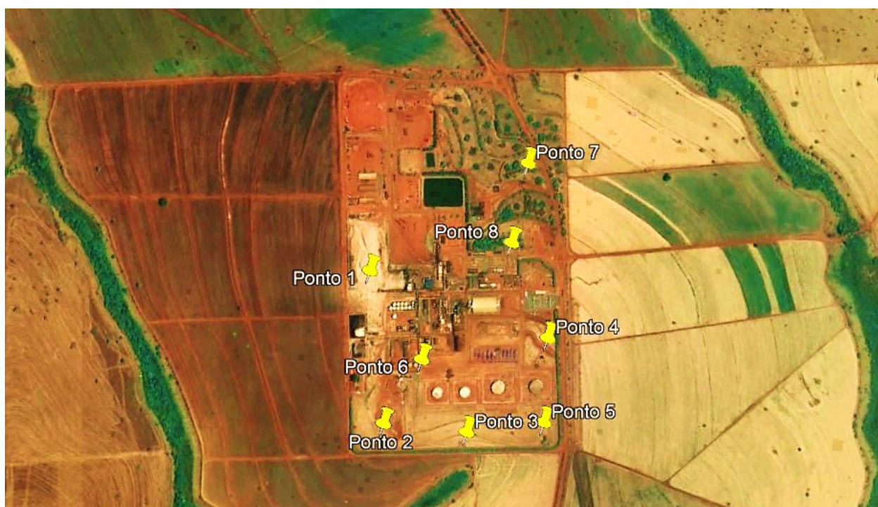
Figura 14 – Pontos de captação de águas subterrâneas dentro do parque industrial da companhia
