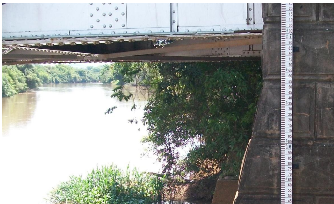
Figura 8. Régua da Ponte Metálica no Rio Mogi Guaçu, Porto Ferreira, SP. Seguindo 4 Km em direção ao fundo da figura (à montante) situa-se a área de estudo do presente trabalho. Crédito da foto: Sergio A. Antonini.
