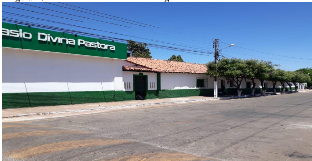
Figura 16 - Prédio da Escola Normal Regional “Dom Inocêncio” em Gilbués.
