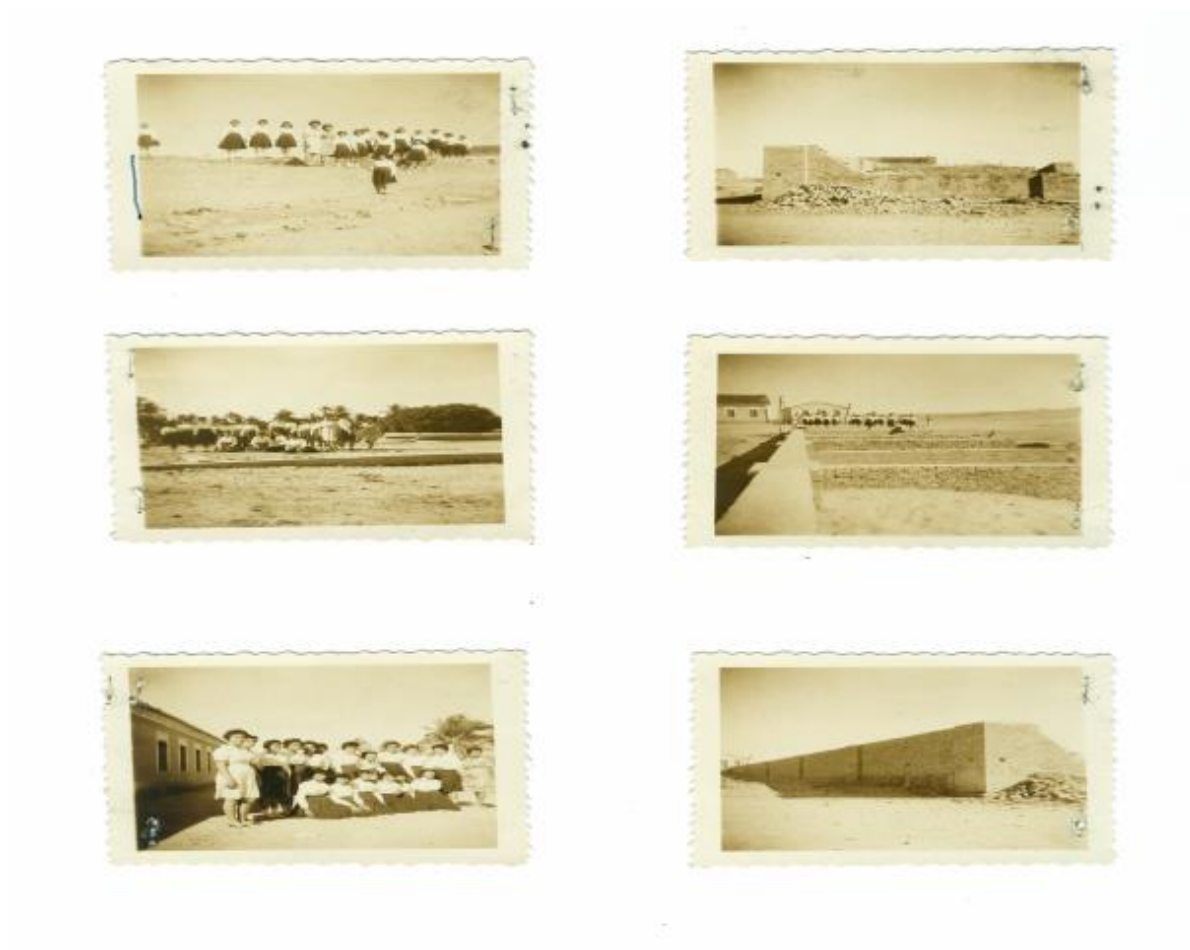
Figura 15 - Fotografia referente à construção da sede própria da ENR de Gilbués
