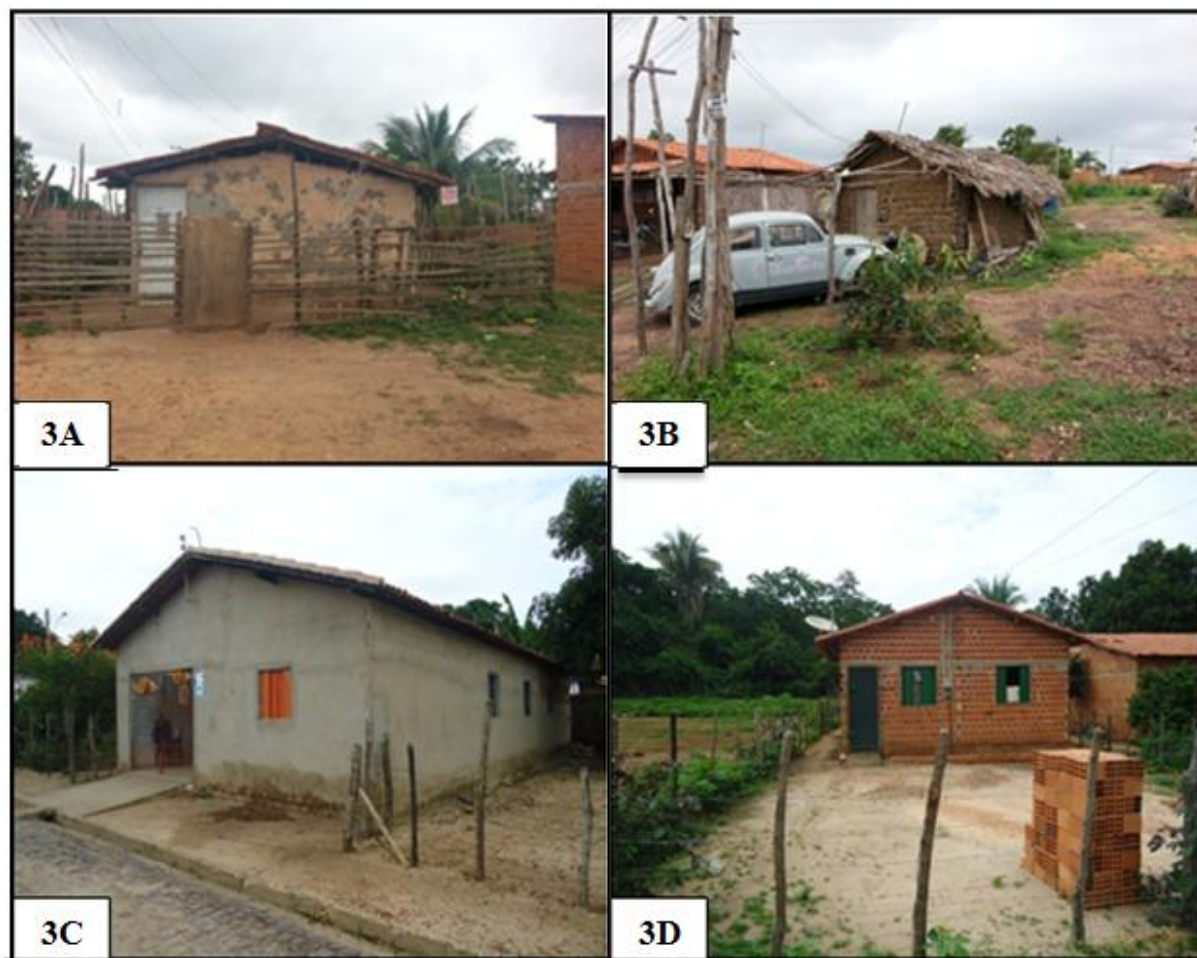
Mosaico Fotográfico 3– Tipos de residências no bairro Monte Verde
