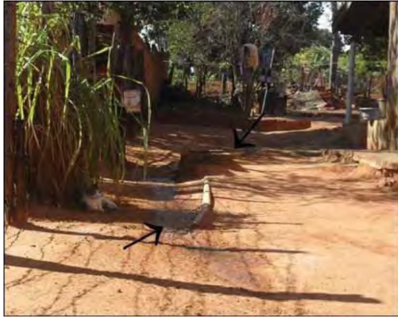
Figura 15 – Exemplo de fossa simples domiciliar com lançamento de esgoto. Em destaque o cano de PVC de onde é lançado o esgoto doméstico.
