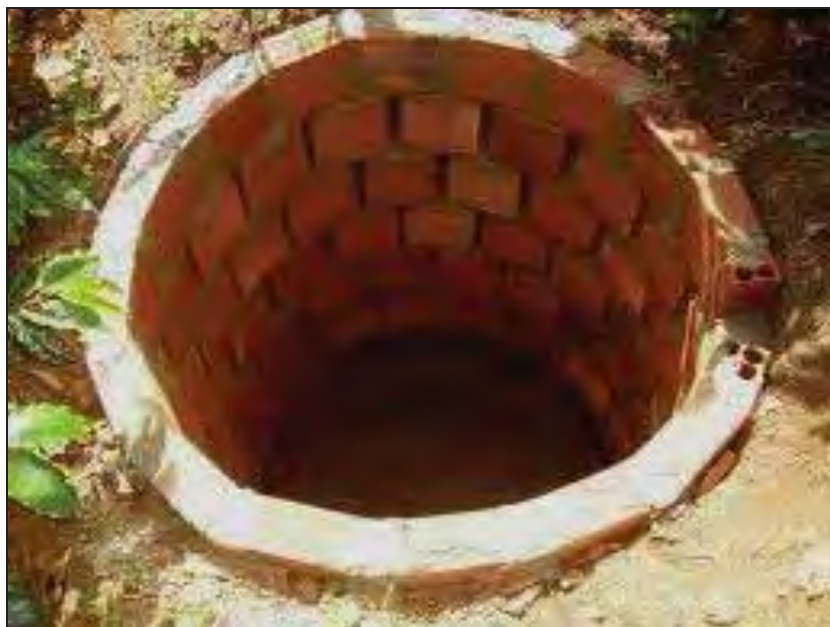
Figura 19 – Exemplo de fossa simples ou negra revestida.
