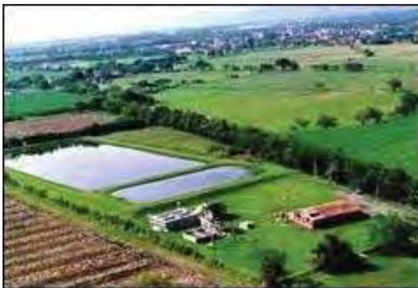
Figura 35 – Lagoa anaeróbia seguida por lagoa facultativa Fonte: http://www.aquafojo.pt/4682.html?*session*id*key*=*session*id*val*
