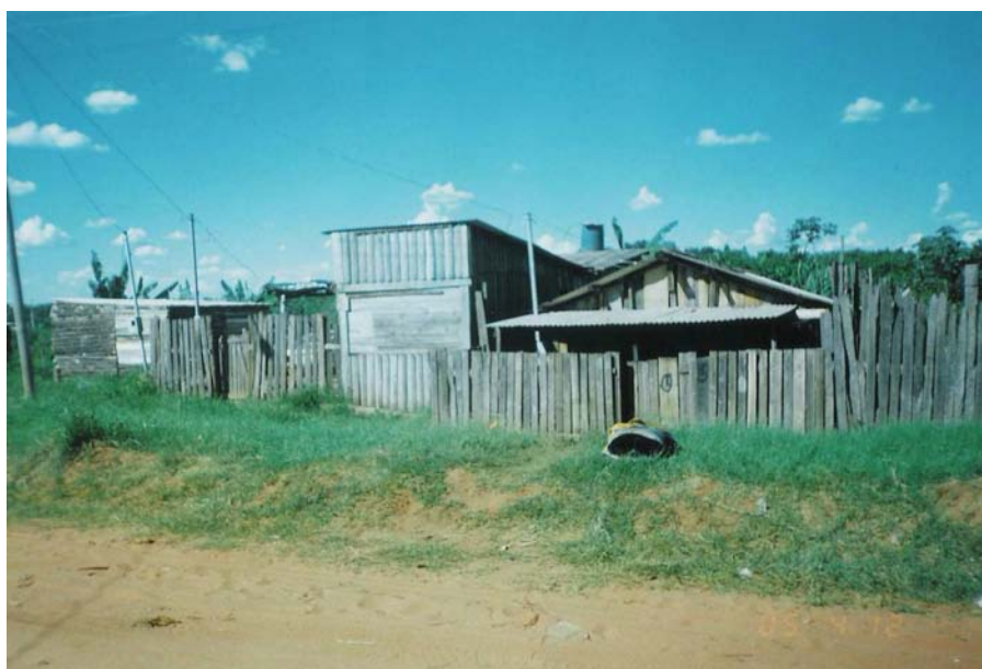
Figura 33: Barracos construídos na periferia de Ribas do Rio Pardo no Bairro Jabour, pelas famílias de trabalhadores das carvoarias Foto: Altamira Pereira, 2005
