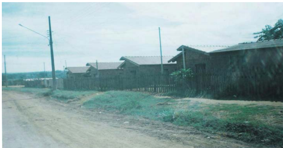
Figura 35: Casas construídas através de um projeto da prefeitura com a Caixa Econômica Federal.
