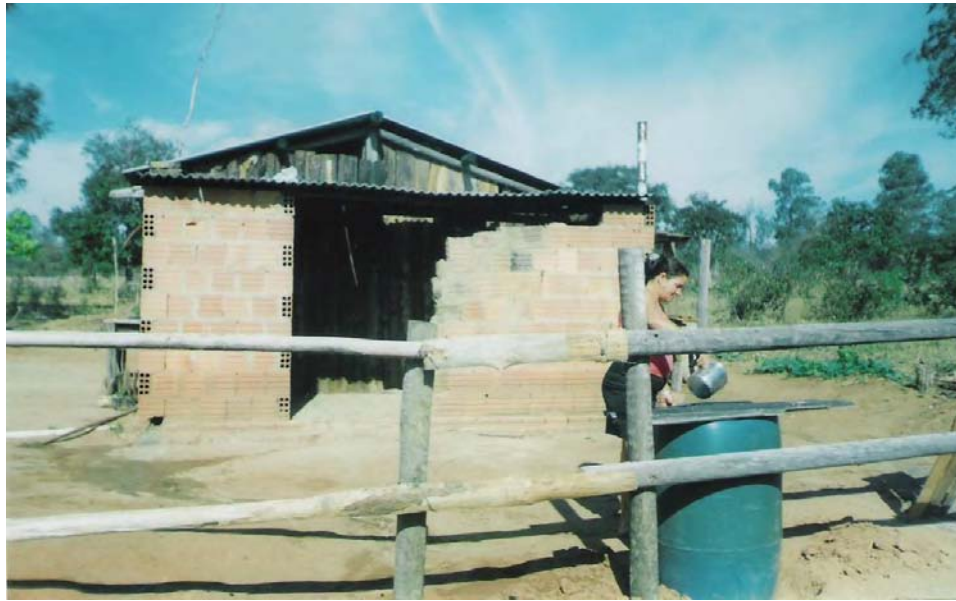
Figura 27: Moradia de madeira, com um cômodo (cozinha) de alvenaria, destinada aos trabalhadores das carvoarias. Foto: Altamira Pereira, 2006
