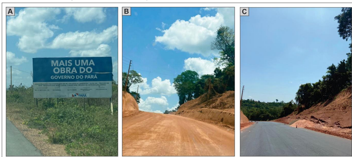
Figura 29 A: Placa indica os valores e prazos para as obras de pavimentação da PA-370, trecho Transuruará. B: trecho ainda não finalizado, sem pavimentação asfáltica nas proximidades da UHE no rio Curuá Una em agosto/2023. C: trecho já finalizado em setembro/2023
