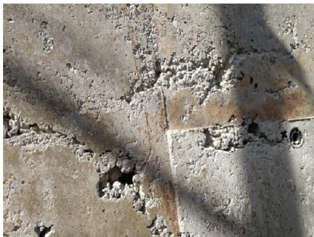
Figura 3 - Fenômeno da segregação
