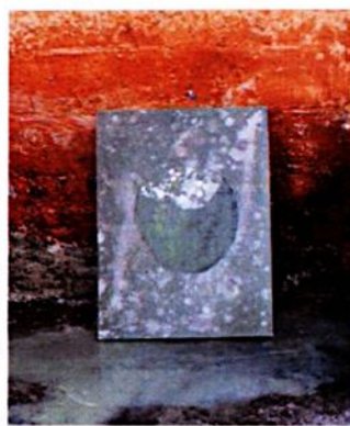
Figura 86 – ... remoção com jato de água.
