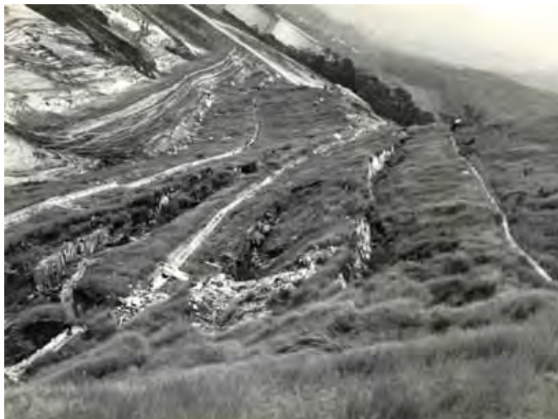
Figura 28. Registro histórico do desmonte das encostas rochosas da Serra do Mar.
