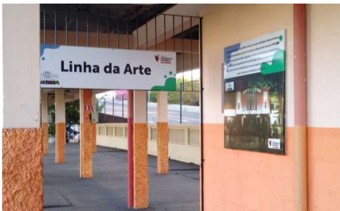
Figura 28: Interior da plataforma da “Linha da Arte”
