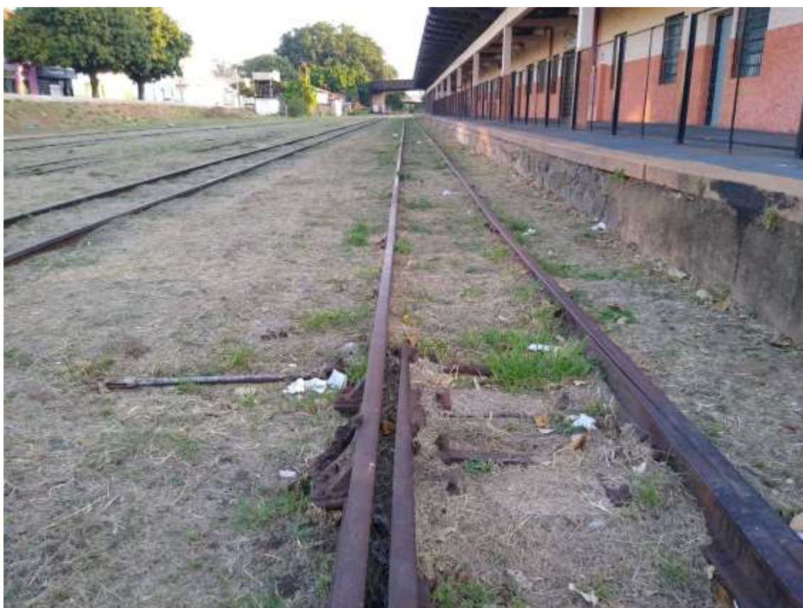
Figura 30: Via férrea com o punho de AMV retirado
