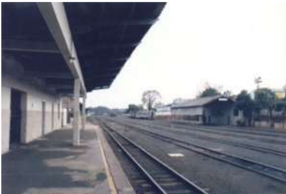
Figura 19: Imagem original retirada na posição 7
