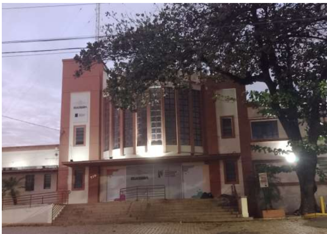
Figura 72: Fachada da Estação Ferroviária de Presidente Prudente, 2025
