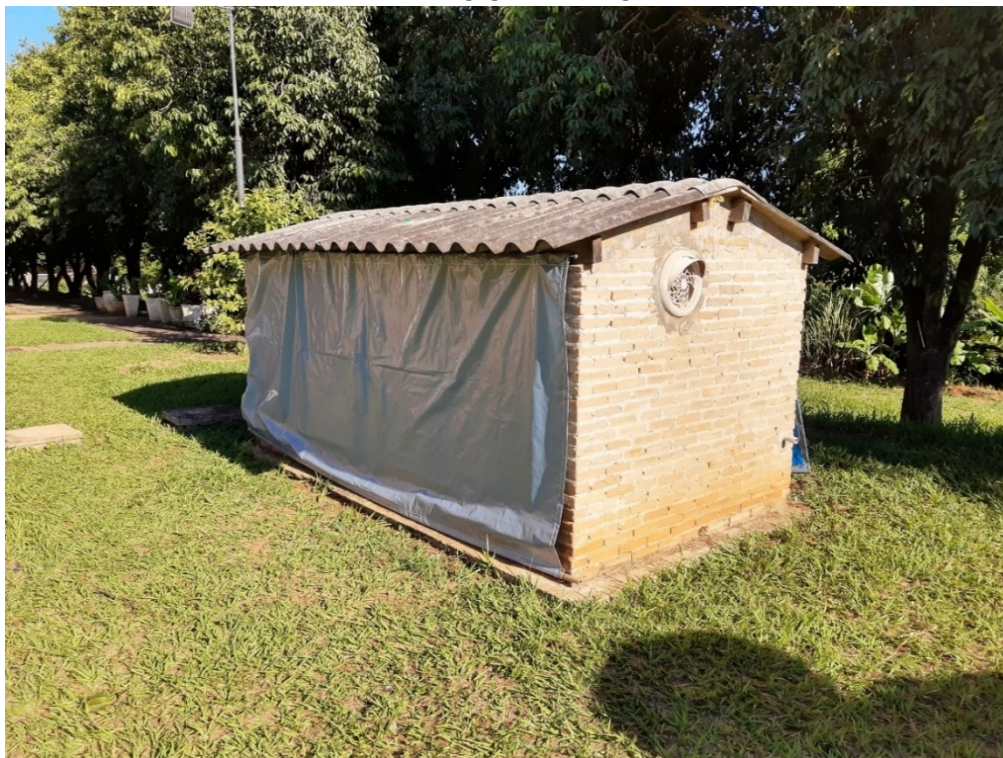
FIGURA 13. GALPÃO EM ESCALA REDUZIDA COM TELHA DE FIBROCIMENTO
