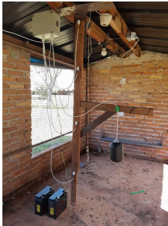
FIGURA 21. INSTALAÇÃO DOS SENSORES DENTRO DO GALPÃO COM TELHA TERMOACÚSTICA
