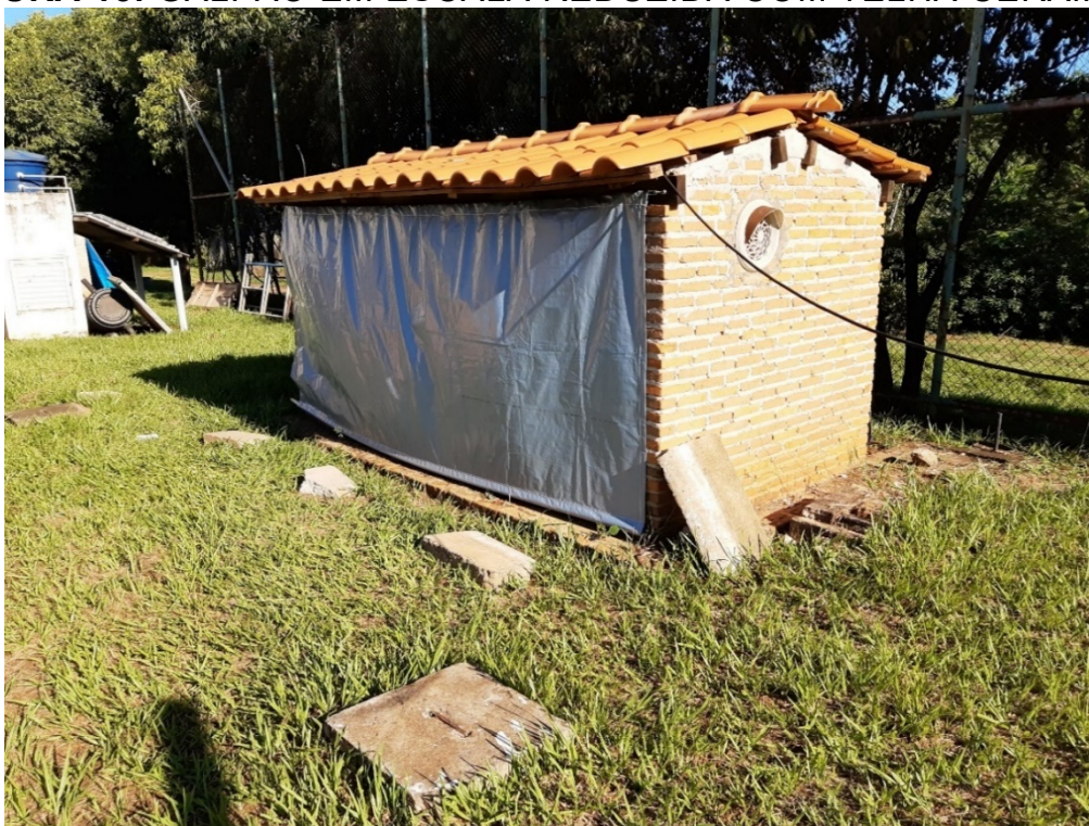
FIGURA 15. GALPÃO EM ESCALA REDUZIDA COM TELHA CERÂMICA
