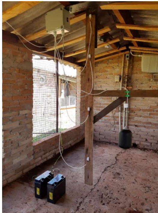
FIGURA 20. INSTALAÇÃO DOS SENSORES DENTRO DO GALPÃO COM TELHA DE FIBROCIMENTO
