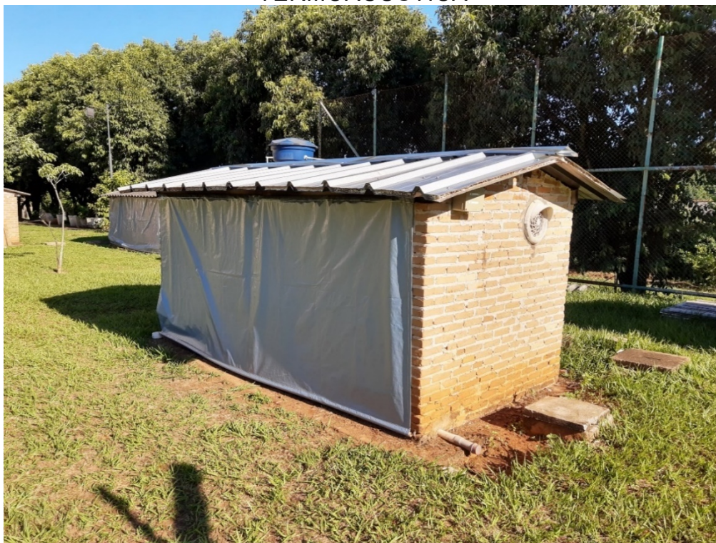
FIGURA 14. GALPÃO EM ESCALA REDUZIDA COM TELHA TERMOACÚSTICA
