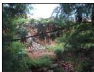
Figura 16: Erosão na saída da canalização.
