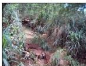
Figura 10: Outras formas de erosão no percurso do canal.
