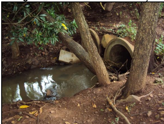
Figura 5.12 - Início da canalização
