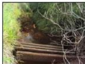
Figura 13: Obras para diminuir a velocidade da enxurrada após a canalização.
