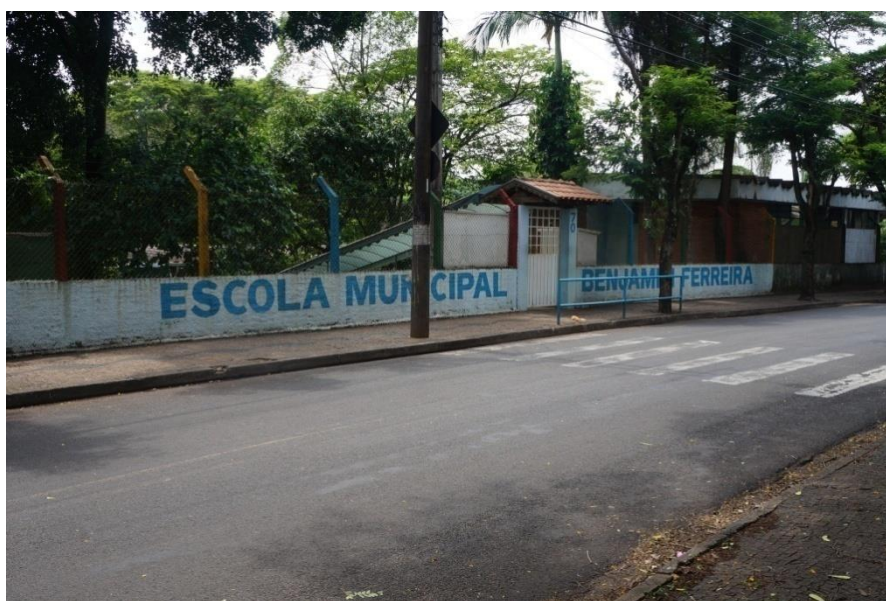
Figura 01: Fachada da Escola Municipal Benjamin Ferreira. Fonte: Autora.
