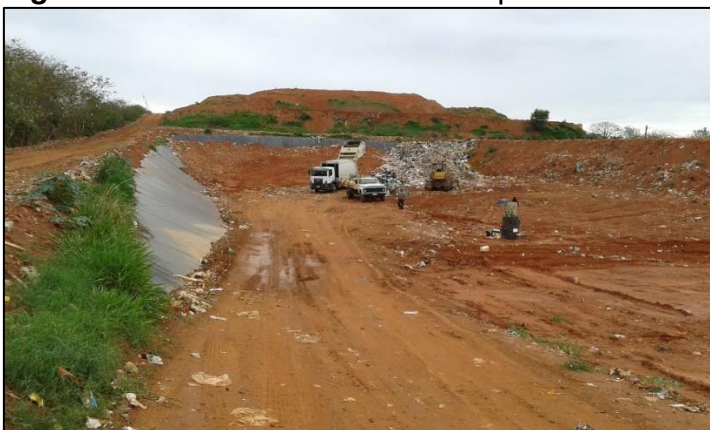
Figura 16 – Aterro sanitário municipal
