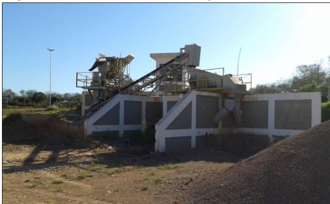
Figura 19 - Usina de Reciclagem de Resíduos da Construção Civil
