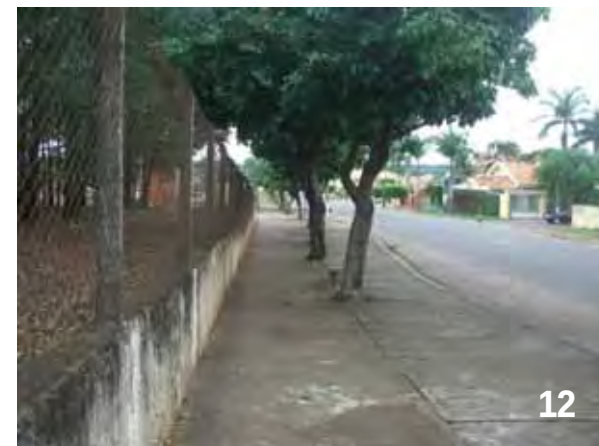
Figura 20 – Pavimentação com placas de concreto. Fonte: MANO, L. (2012)
