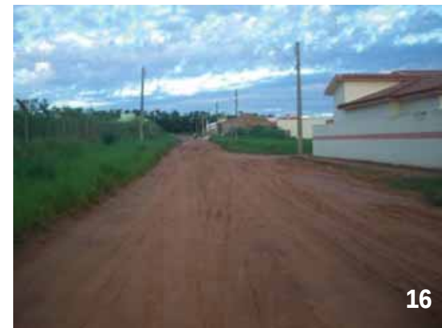
Figura 24 – Via não pavimentada.
