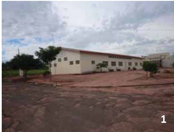
Figura 09 – Via em condições precárias ao lado do CVI.
