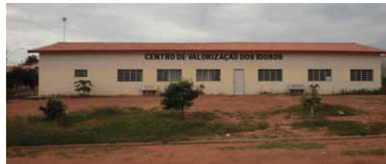
Figura 04 – Centro de Valorização dos Idosos no município de Bastos Fonte: AIHARA, F. (2011).
