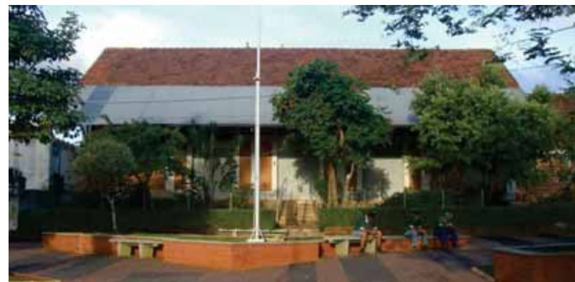
Figura 06 – Prédio do antigo judô de Bastos.
