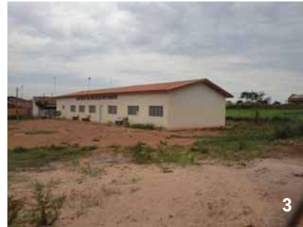
Figura 11 – Condições do entorno do CVI.
