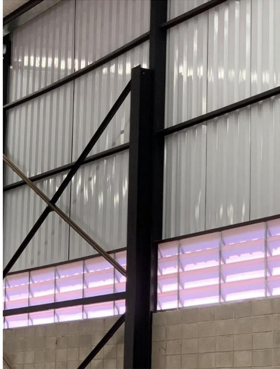
Figura 12 - Peças metálicas provenientes de demolição reutilizadas em construção de galpão.
