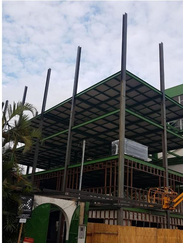
Figura 5 - Processo de construção da estrutura do edifício com pavimentos preenchidos.
