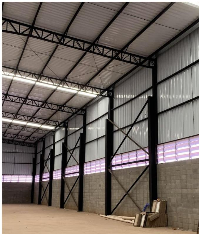
Figura 11 - Galpão com estrutura metálica feita com materiais reutilizados.
