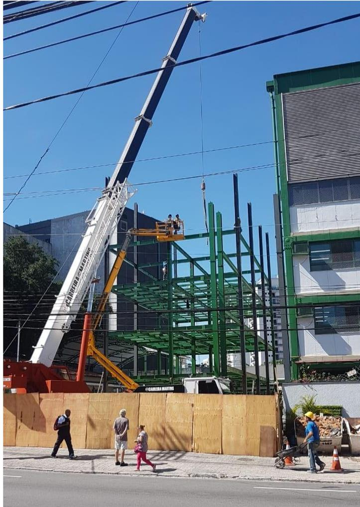
Figura 4 - Processo de construção da estrutura do edifício com materiais metálicos.
