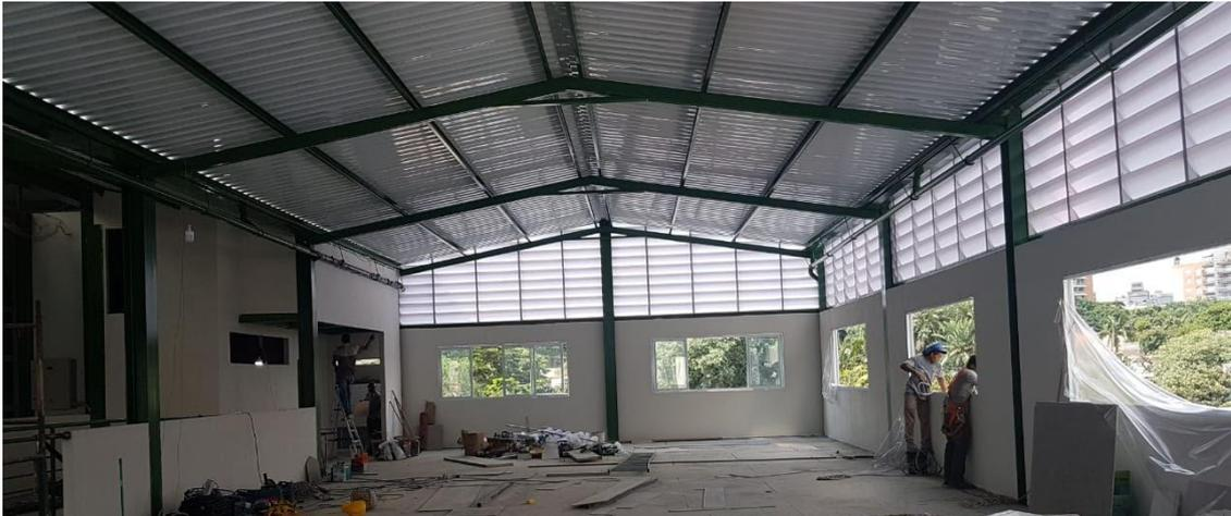
Figura 7 - Parte interna do último pavimento do edifício com fechamento lateral adicionado.
