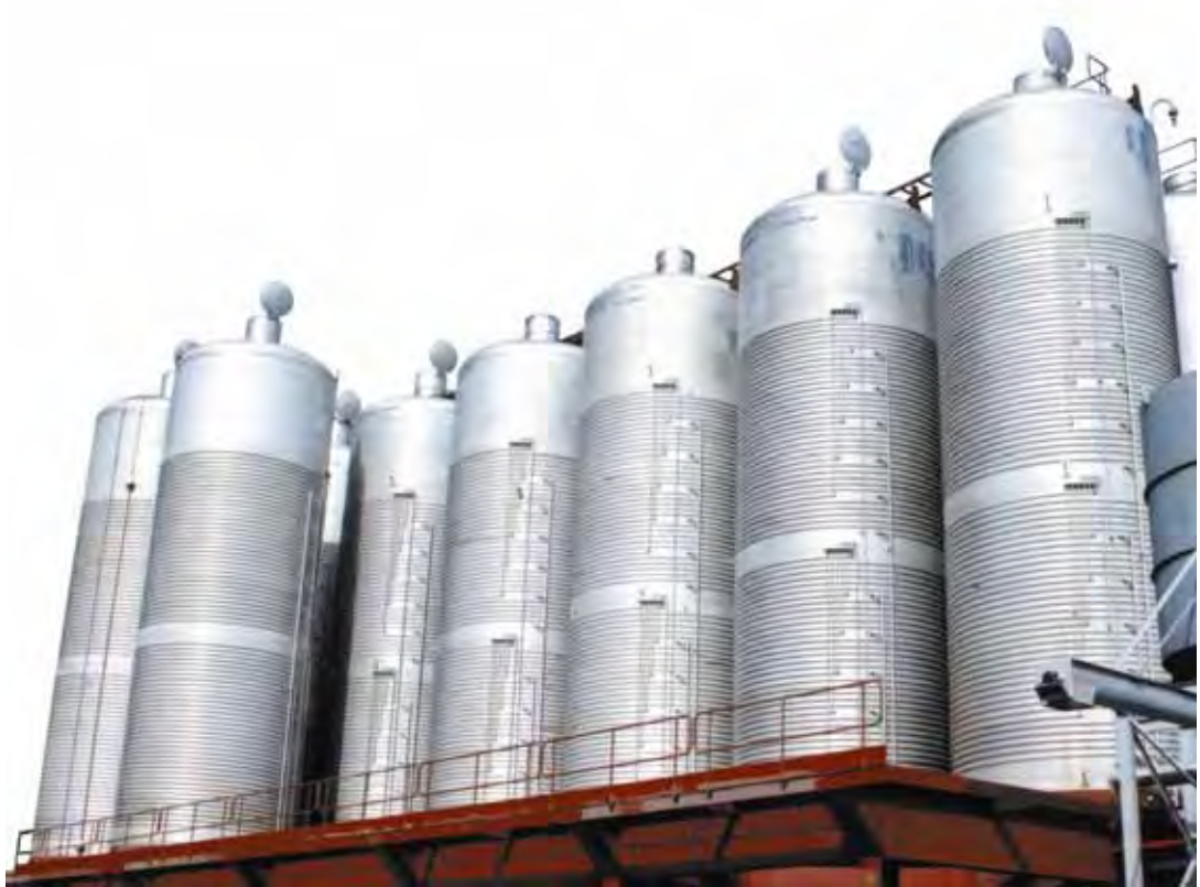
Figura 04: Fermentadores cilíndricos ainda em fase de montagem (sem isolamento térmico). Fonte: DEDINI (2008).
