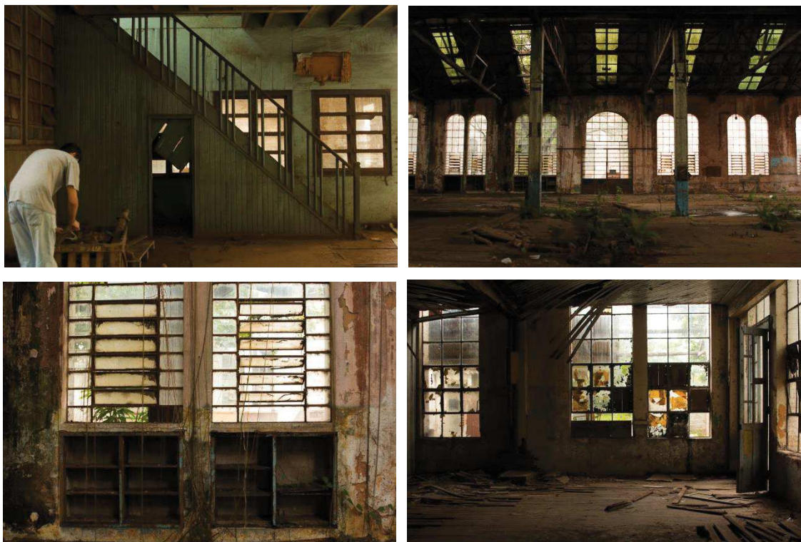
Figura 31/32/33/34: Registros do galpão utilizado como locação.
