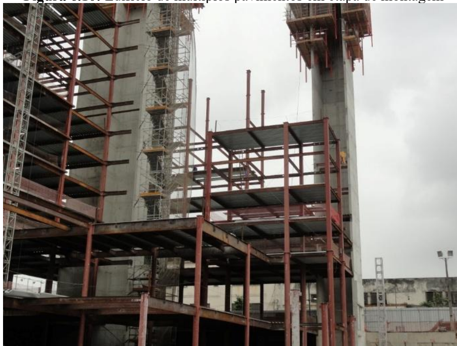
Figura 6.10: Edifício de múltiplos pavimentos em etapa de montagem
