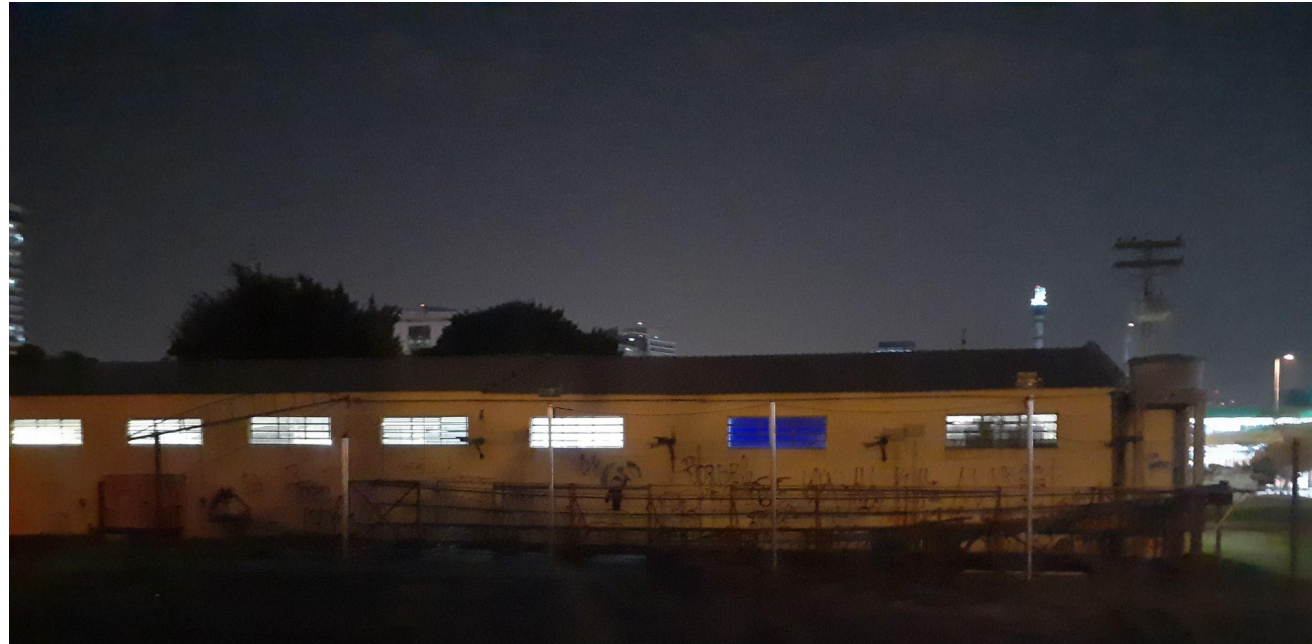
Figura 112 - Estrutura metálica do hangar atrás da Marcenaria do Instituto de Artes da Unesp.
