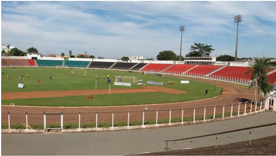
Figura 6: Estádio já finalizado e com os jogadores em campo treinando
