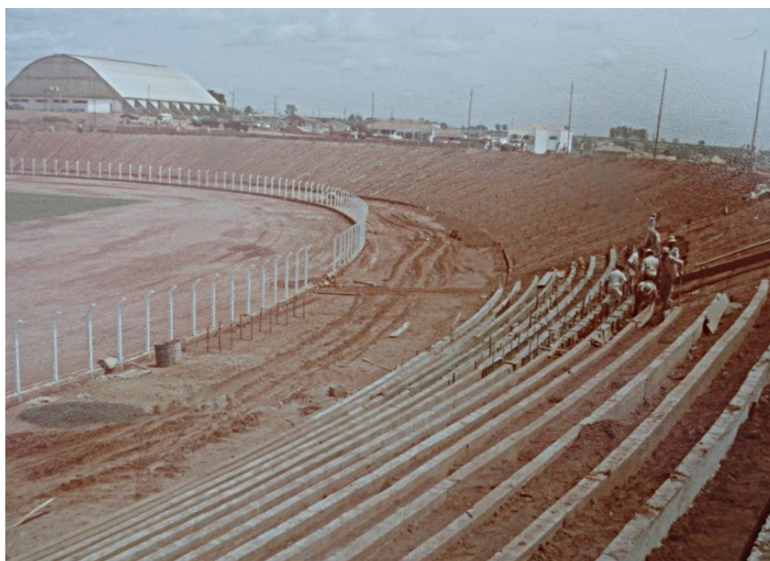
Figura 5: Construção do estádio Taquarão
