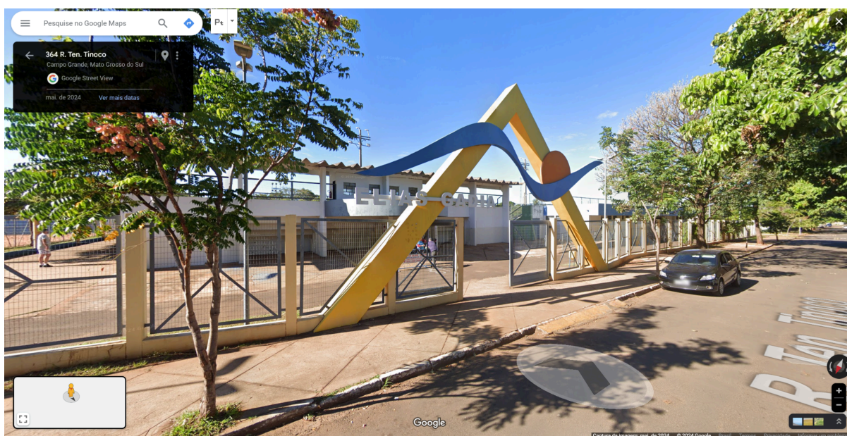
Figura 35 - Imagem externa da Praça Elias Gadia, vista 2
