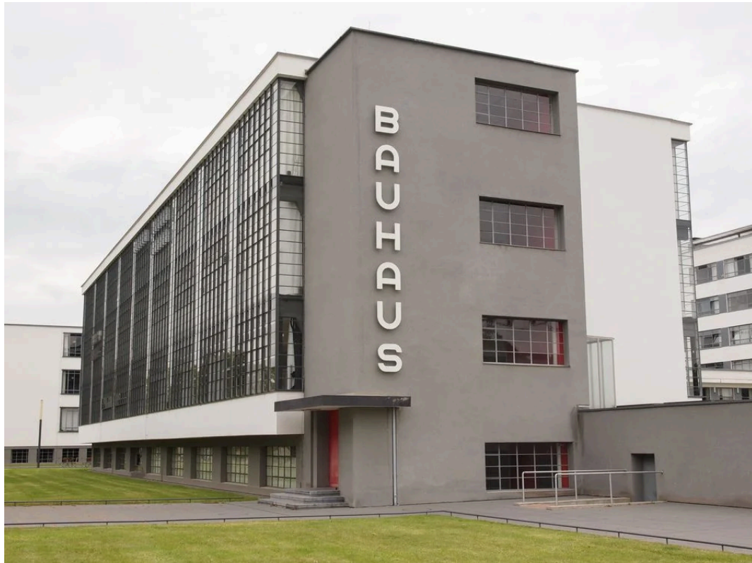
Figura 6: Escola de Bauhaus, projetada por Walter Gropius, em 1925, Dessau, Alemanha.
