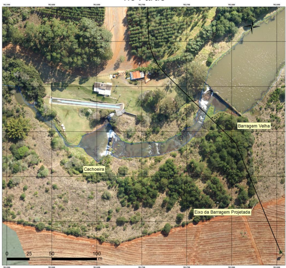
Figura 11 – Vista panorâmica aérea da situação da área do antigo barramento do rio Pardo
