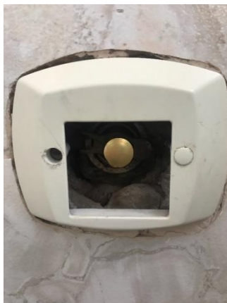
Figura 12: Descarga danificada.
