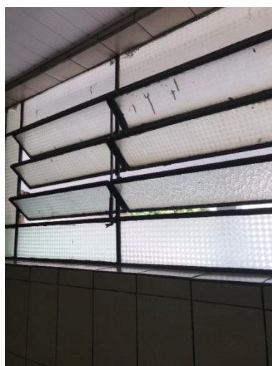
Figura 11: Vidros danificados.
