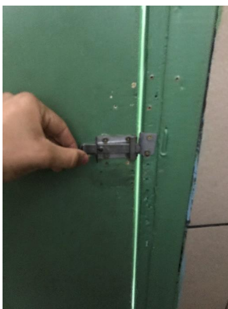
Figura 9: Travas danificadas.
