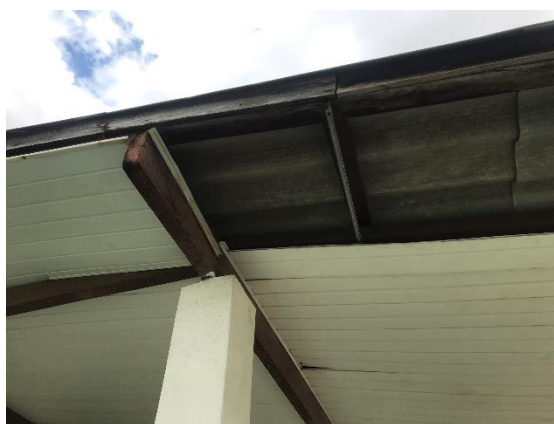
Figura 8: Foro acima do bebedouro quebrado.
