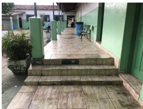
Figura 4: Imagem de degraus sem adesivos antiderrapantes.
