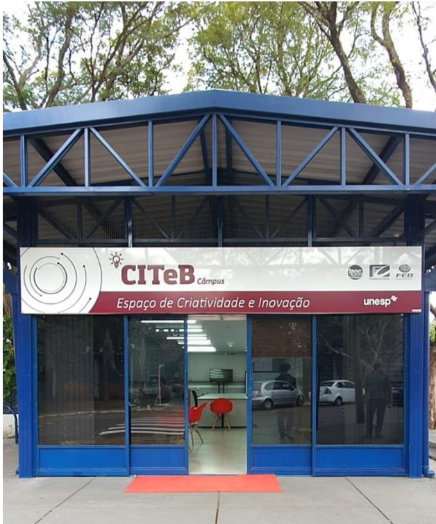
Figura 1 - CITEB – parte externa
