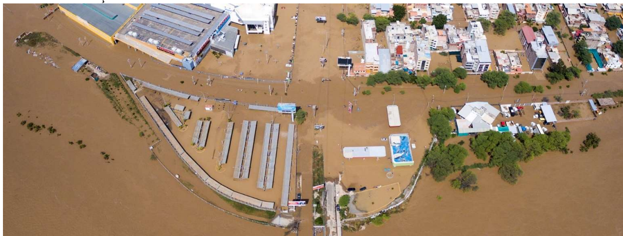
Inundação da cidade de Piura em 27.03.2017. Outra vista do shopping Open Plaza e da principal área de urbanização inundados.
