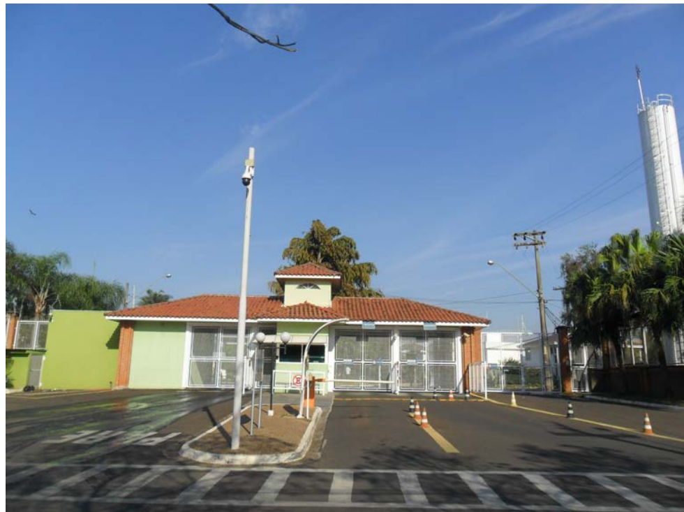
Figura 2: Entrada do “Condomínio Jardim Botânico”. Fonte: MESSIAS, 09/09/2017.
