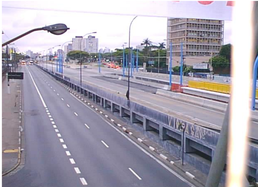
Figura 09 - Emprego da técnica em trecho da Avenida do Estado (SP) com a implantação do Fura-Fila acima do rio Tamanduateí.
