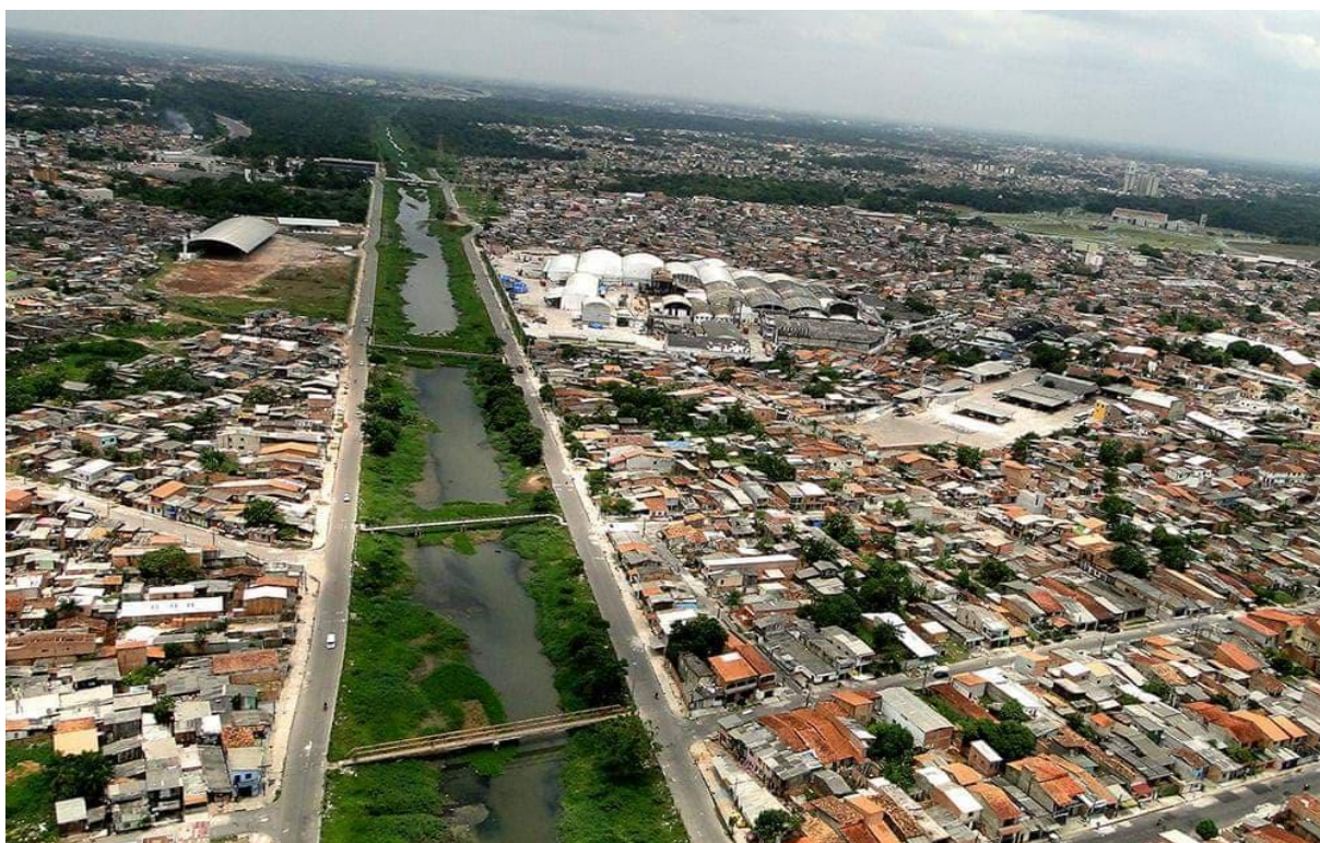
Figura 27 - Rua do Canal São Joaquim após retificação, Belém (PA).
