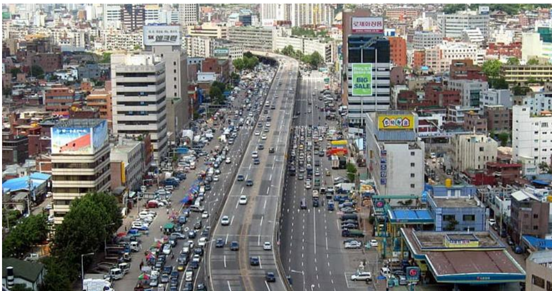
Figura 34 - Foto do Córrego soterrado sob a ponte na Coreia do Sul
