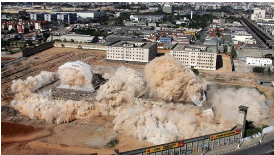
Figura 43 - Foto da demolição parcial da penitenciária em 2002
