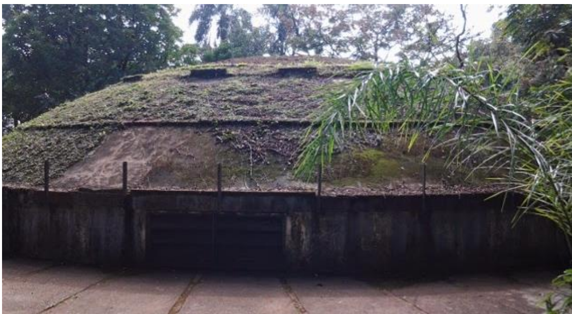
Figura 46 - Casa de Bomba antigo Reservatório
