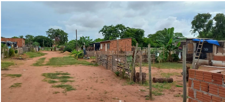
Figura 8: Ocupação São João, casas construídas de alvenaria. Fonte: FRANQUELINO, A.R., 2024.
