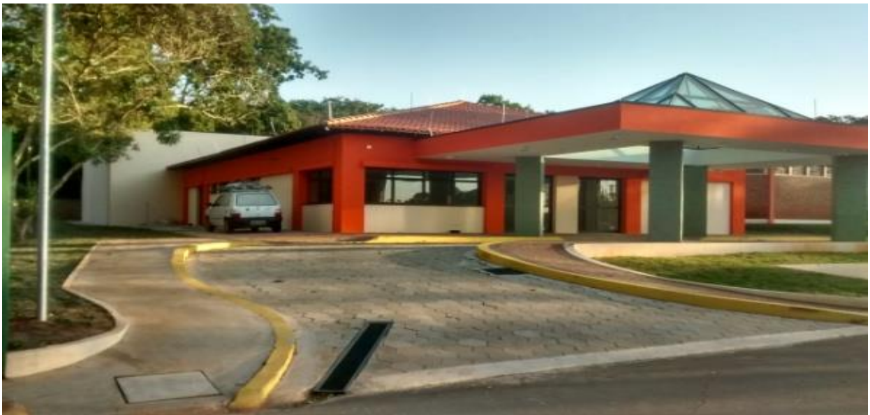
Figura 6: Clínica de radioterapia recém construída (Foto tirada em 24/06/2015 – Hospital Unimed Bauru)
