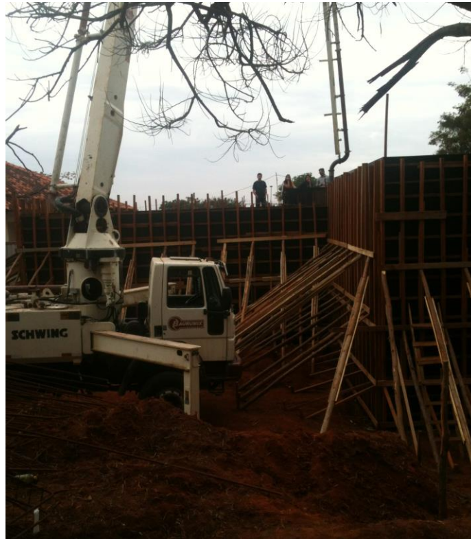
Figura 2: Processo de concretagem da casa mata (Foto tirada em 13/08/2014 - Hospital Unimed Bauru).
