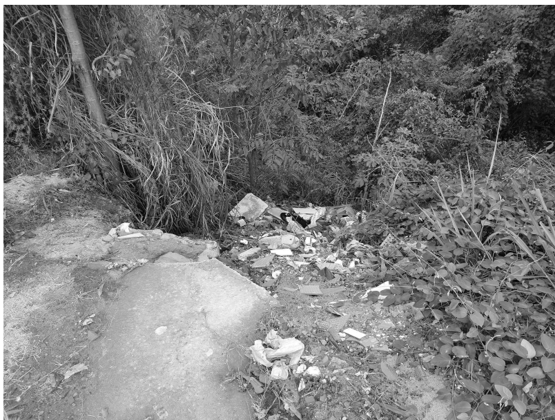
Figura 17: Ponto final da galeria subterrânea.
