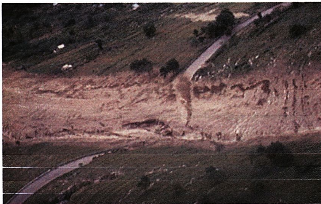
Figura 1 - Escoamento de lama causado pela chuva numa região montanhosa.
