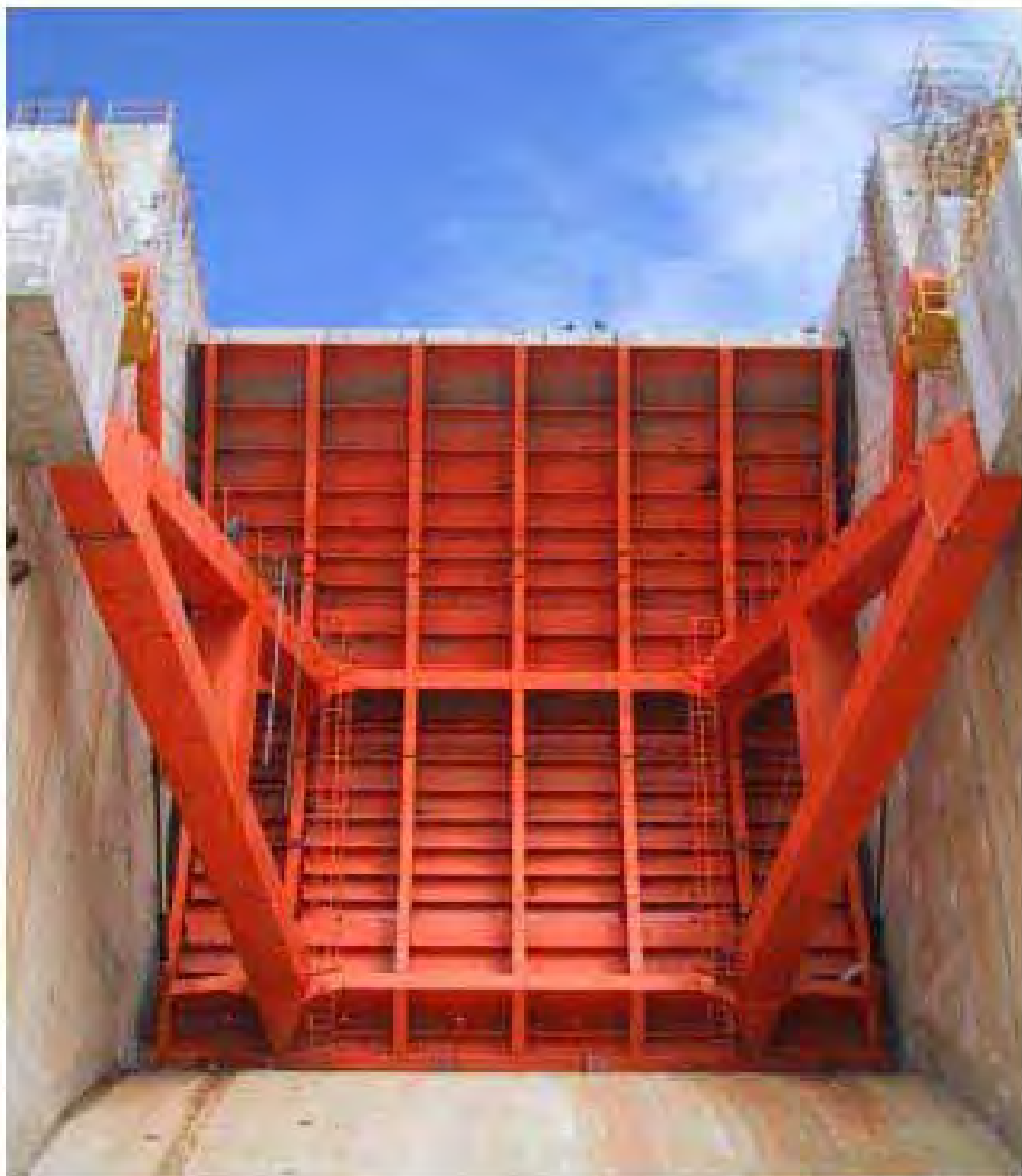
Figura 3 – Comporta segmento de dois braços montada na obra.
