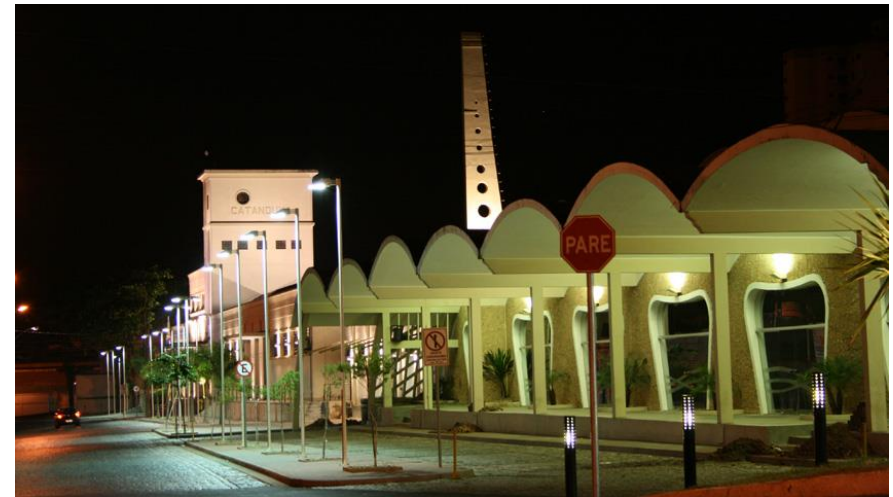
Figura 14 - Antiga rodoviária de Catanduva e, ao fundo, estação ferroviária, hoje Estação Cultura. Fonte: http://catanduva-cult.blogspot.com.br/p/fotos-cidade.html
