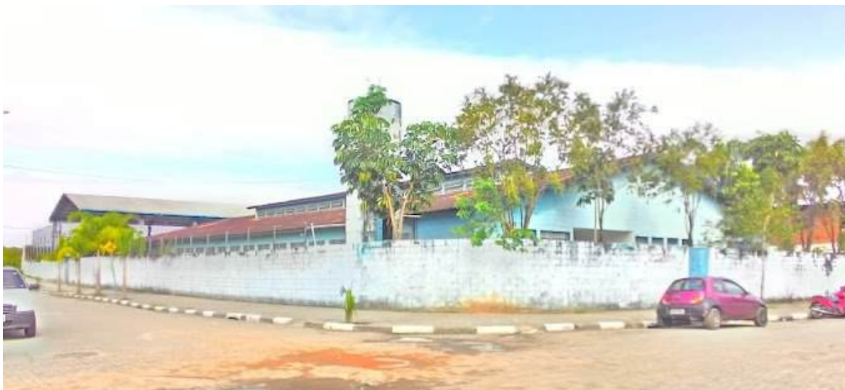
Figura VI: Escola Estadual Jardim Vicente de Carvalho, escola de ensino regular, subordinada à Diretoria de Ensino de Santos – Localizada no bairro Vicente de Carvalho. Centro de Bertioga - SP. (Fonte: Google Maps)
