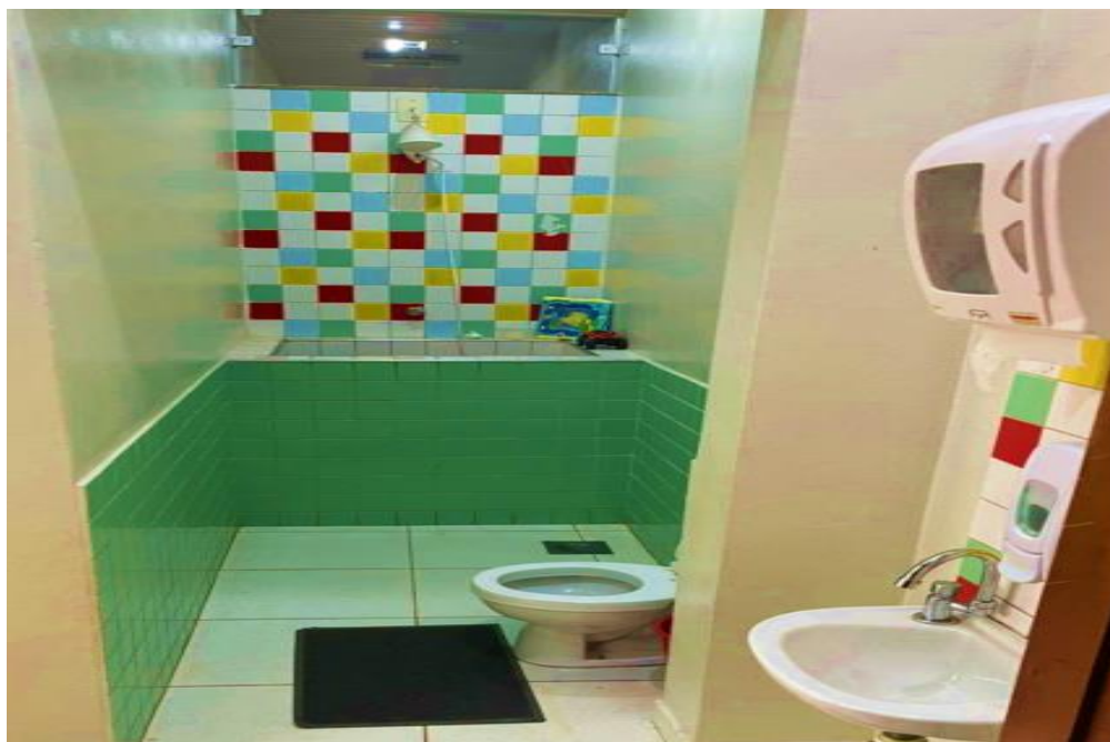
Figura 43 - Foto do banheiro do maternal I
