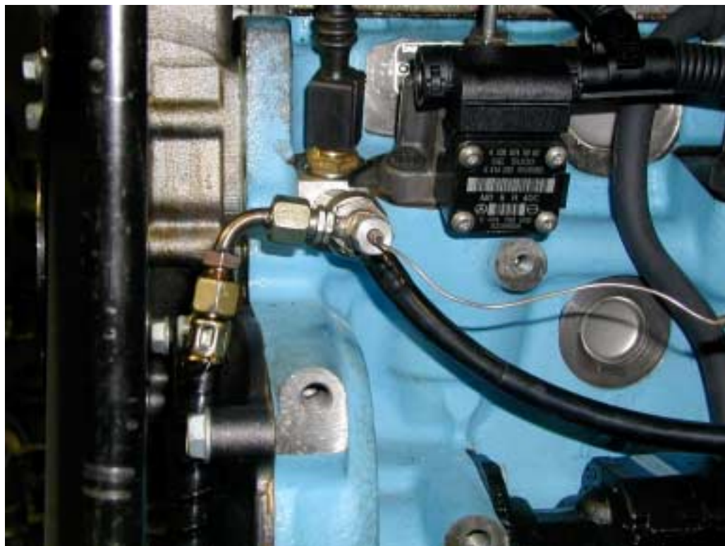
Figura 48 – Detalhe do ponto de medição da pressão de combustível
