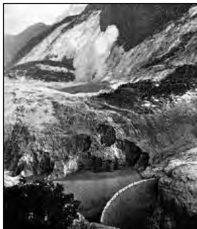
Figura 1.3 – Barragem em forma de arco e depósito de rocha a montante no Vale Vajont (Itália). Fonte: FRITZ, 2002.
