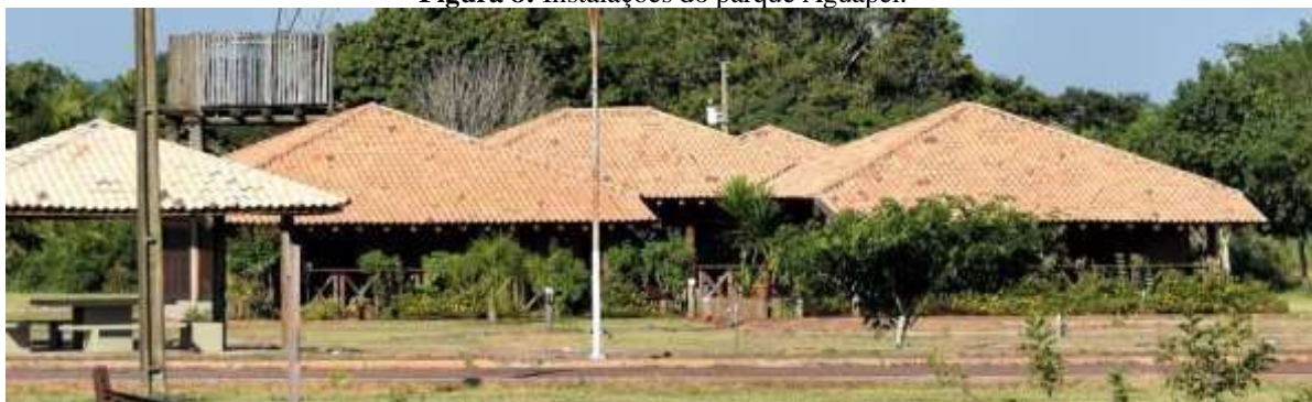
Figura 8: Instalações do parque Aguapeí.
