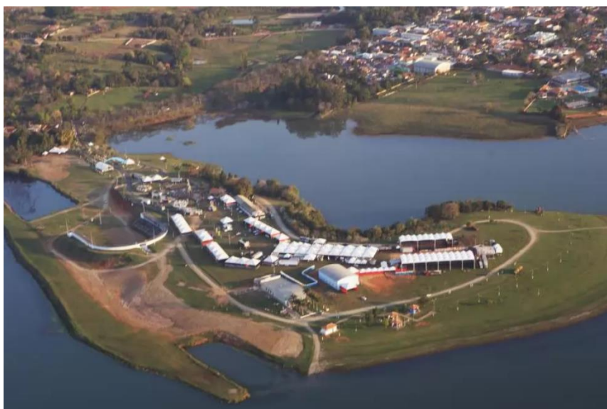
Figura 7 - Parte da Área Urbanizada (Município de Carlópolis) no entrono do reservatório da UHE Chavantes.
