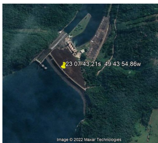
Figura 1 – A Barragem da UHE Chavantes
