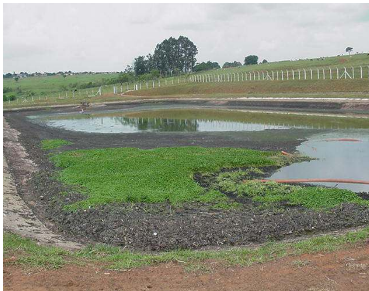
Figura 14: Lagoa de tratamento – ETE Estrela do Norte. Fonte: Relatório I (CPTI, 2004).
