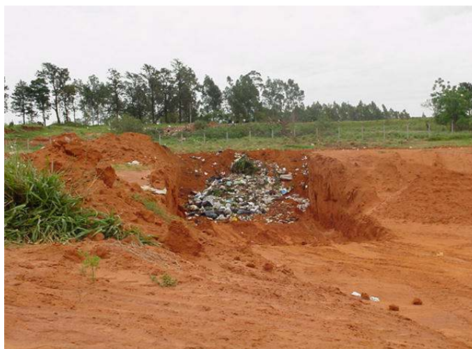
Figura 17: Destino final em aterro em vala no município de Tarabaí. Fonte: Relatório I (CPTI, 2004).
