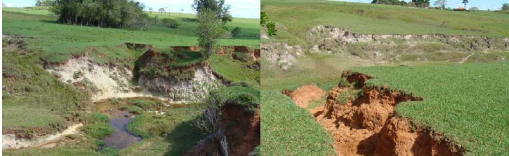
Figura 187: Camada de latossolo sobre solo hidromórfico provavelmente carregados por ação dos processos erosivos no local.
