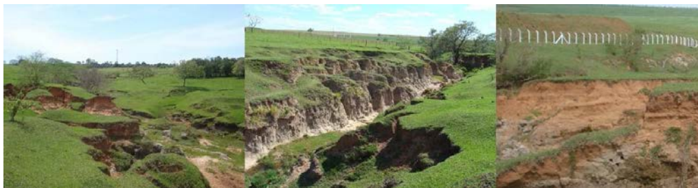
Figura 186: Prolongamento do processo erosivo iniciado à montante na cidade de Estrela do Norte e que chega contornar a ETE de Estrela do Norte.
