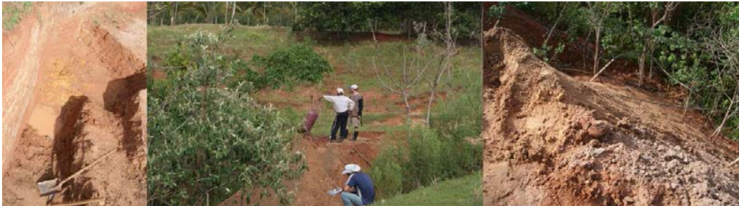
Figura 167: Da esquerda pra direita observamos a escavação de reservatório em área de nascente; deslocamento de solo à jusante da mesma em área de mata ciliar. Autor: Éder Pereira dos Santos, 2012.
