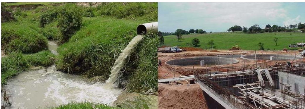
Figura 16: Da esquerda para a direita, antigo local de lançamento in natura do esgoto e construção da ETE de Pirapozinho. Fonte: Relatório I (CPTI, 2004).
