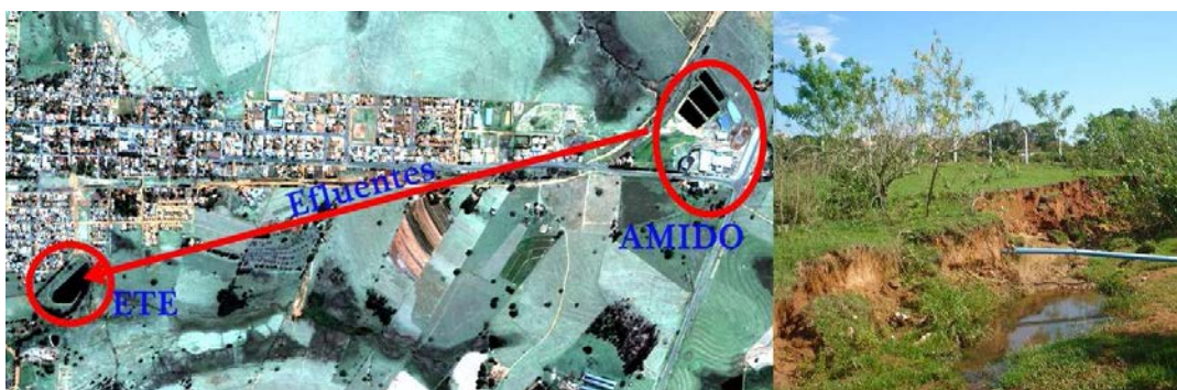
Figura 179: Espacialização do trajeto dos efluentes da fábrica de amido até a ETE por meio de dutos. Vide dutos na figura à direita.
