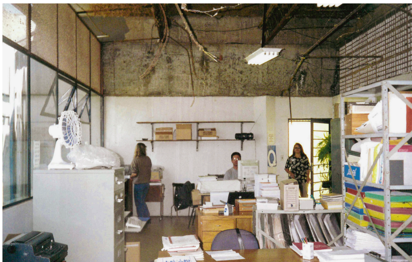
Figura 9. Reforma do teto e instalação do sistema de ar-condicionado (1996/1997). Fonte: Acervo institucional.
