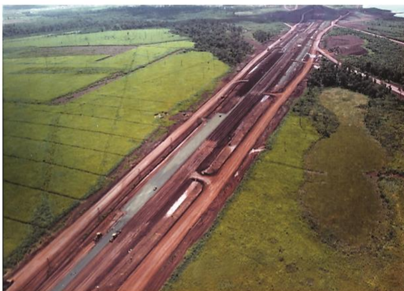
(a) Durante a construção
