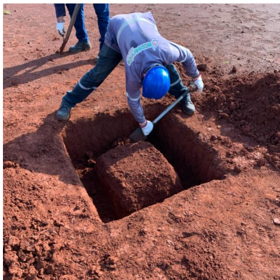
(a) Escavação lateral ao bloco
